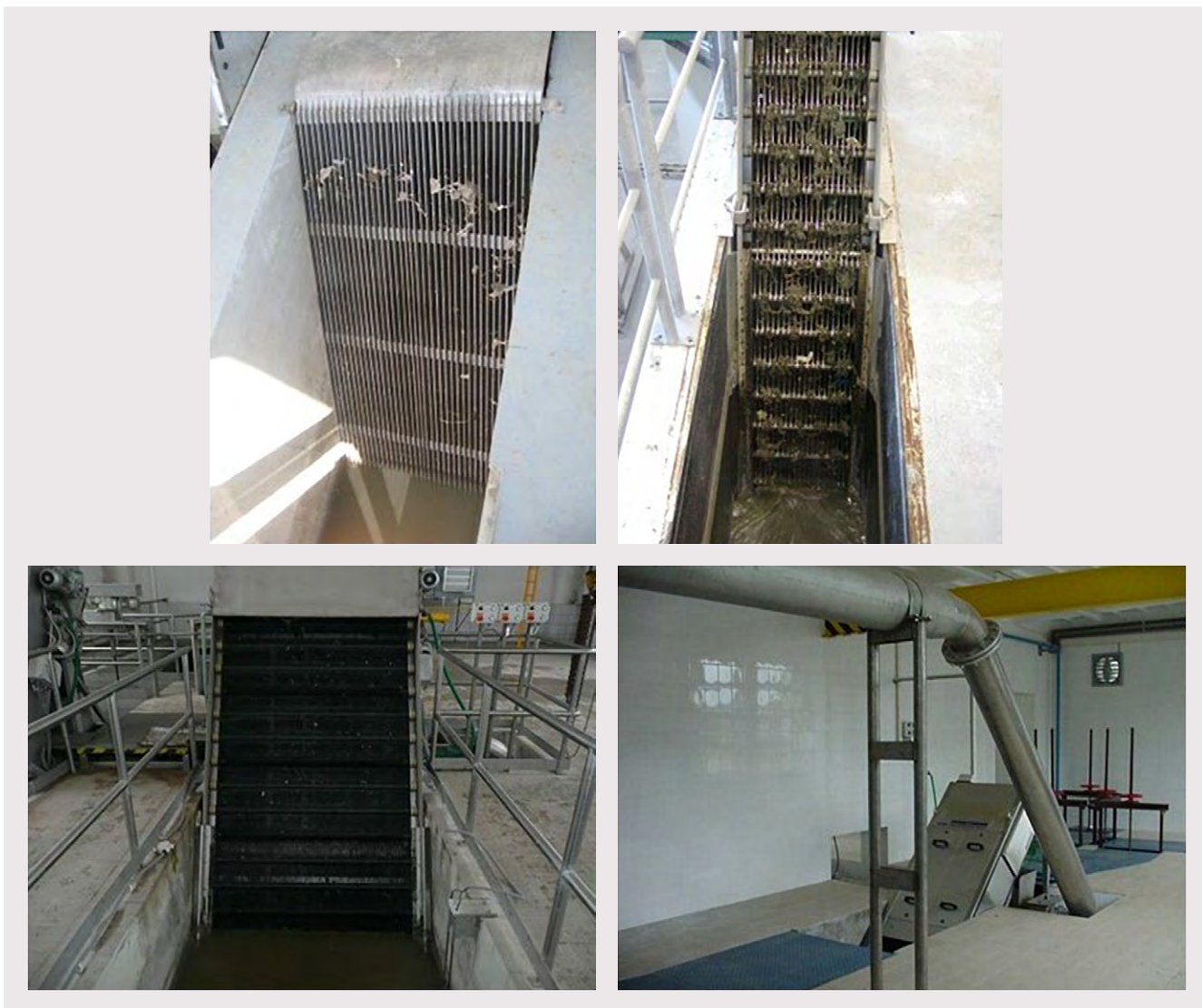
Obrázok 27: Rôzne druhy hrablíc (hore hrubé, dole jemné, vľavo ručne stierané, vpravo strojne stierané, foto: I. Bodík)
